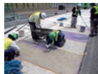
高速道路の床板補強工事において、工期の飛躍的な短縮を実現した炭素繊維強化複合材「ストランドシート®」JCM埋設工法
