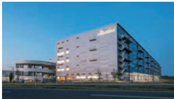
竣工した大型物流施設「MCUD上尾」
