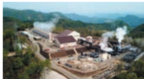
湯沢地熱(株) 山葵沢地熱発電所
