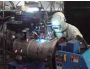
SM65-2505 溶接作業の様子
