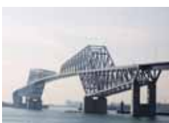
東京ゲートブリッジ
