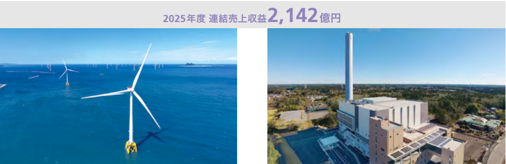
9.6MWの大型風車を支えるジャケット式基礎25基を建設／北九州 響灘洋上ウインドファーム(提供：ひびきウインドエナジー株式会社) シャフト炉式ガス化溶融炉により、資源循環と最終処分量削減に貢献／千葉市 北谷津清掃工場
