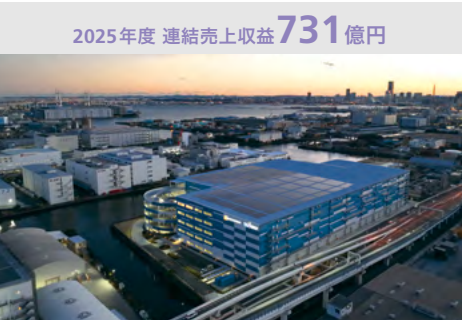
鋼構造技術と環境配慮設計により、「水辺と共存するスマートエネルギー倉庫」の実現に貢献／MFLP横浜新子安
