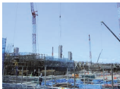
名古屋製鉄所 次世代型熱延ライン建設風景
