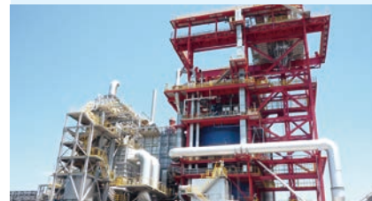
コークス乾式消火設備(CDQ)は、コークスの熱エネルギーを 回収し製鉄所からのCO 2 排出量削減に貢献
