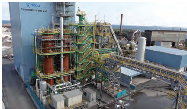
COURSE50試験高炉
