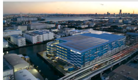
鋼構造技術と環境配慮設計により、「水辺と共存するスマートエネル ギー倉庫」の実現に貢献／MFLP横浜新子安
