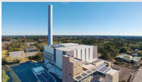
シャフト炉式ガス化溶融炉により、資源循環と最終処分量削減に貢 献／千葉市 北谷津清掃工場
