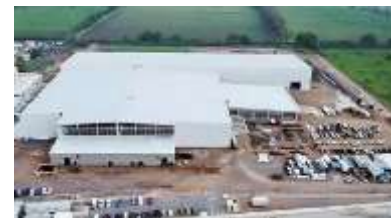
建設中のメキシコ電磁鋼板コイルセンター (2024年10月時点)
