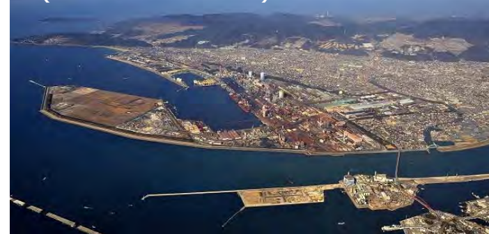
広大な敷地 (和歌山地区全景)
