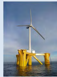
浮体式2MW風力発電設備設置状況
