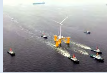
浮体式2MW風力発電設備設置状況
