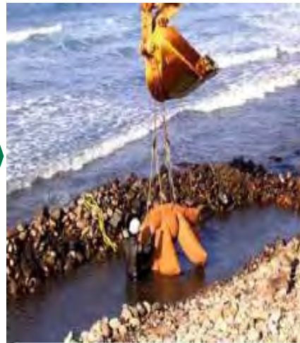
ビバリー®ユニット の設置
