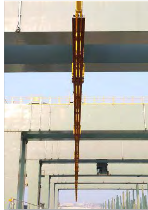
150mレール取扱の様子
