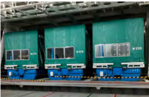
大型エレベーター（一度にロールトレーラー3台）
