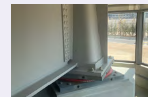
鉄の免震装置「NS-SSB®」
