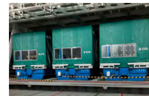
大型エレベーター （一度にロールトレーラー3台）
