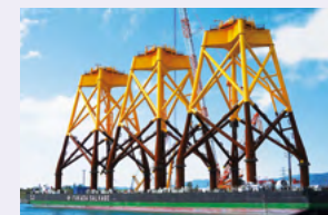
洋上で風車を支えるジャケット式基礎
