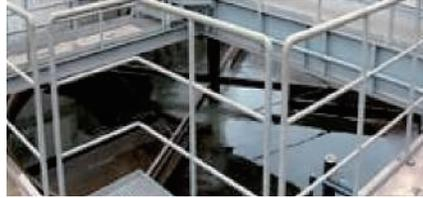
油分を気泡の力で浮かせて除去します。
