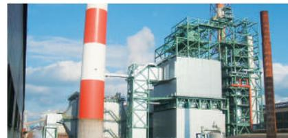
活性コークスを用いた乾式脱硫脱硝法により、排ガス中のSOx(硫黄酸化物)・NOx(窒素酸化物)を除去します。
