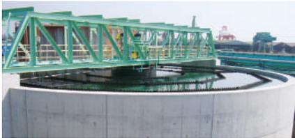
貯留した雨水の不溶解成分を凝集沈殿し除去します。
