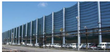
防風ネットの設置により風速を弱めて、原料の飛散を抑制します。
