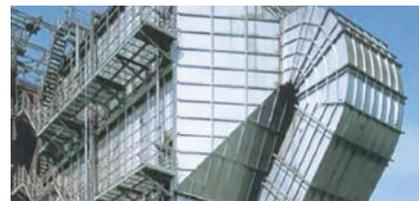
燃焼過程で発生するばいじんをその性状(粒径分布・排ガス中濃度等)に応じて、2種類の集じん機(電気式/バグフィルター式)を使い分けて捕集しています。
