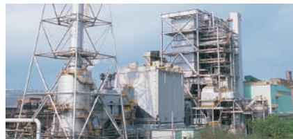
湿式脱硫法により、排ガス中のSOx(硫黄酸化物)を除去します。
