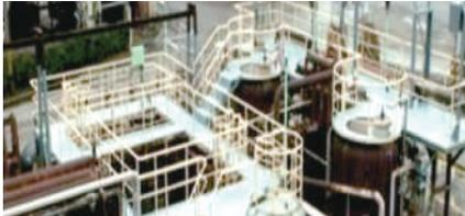
処理した後の排水中に残る不溶解成分を砂の層でろ過し除去します。
