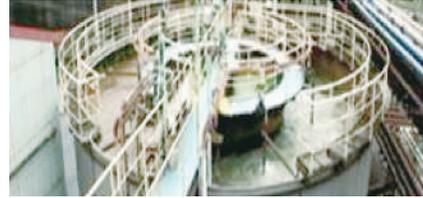
有機物をバクテリアで分解して除去します。
