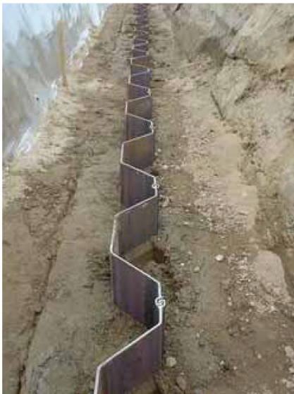
Photo 1 Hat Type Sheet Pile 900
