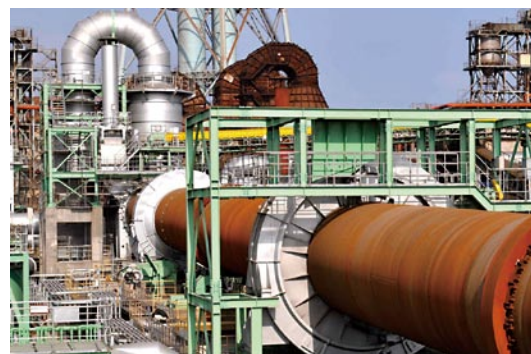
増設RC資源循環炉(鹿島)
