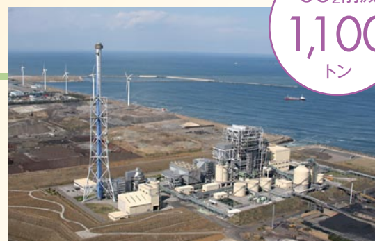
住友金属鹿島火力発電所
