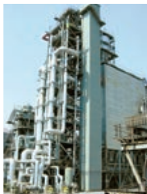
排ガス処理設備(鹿島)
