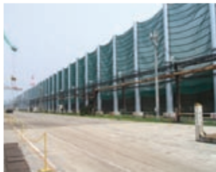
石炭ヤード防風ネット(和歌山)
