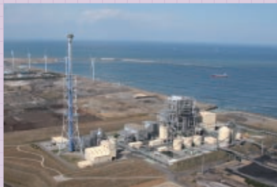
住友金属鹿島火力発電所
