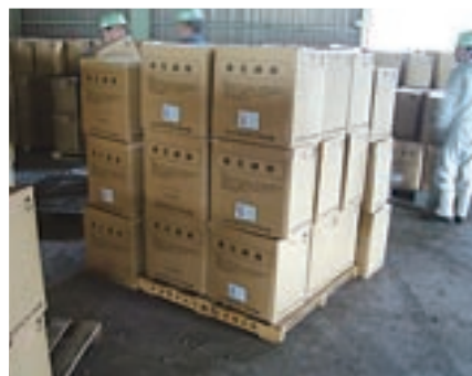
廃石綿の保管(鹿島)
