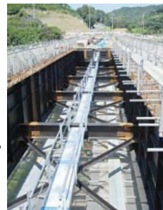
入野橋工事状況
