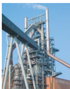
鹿島製鉄所第1号高炉
