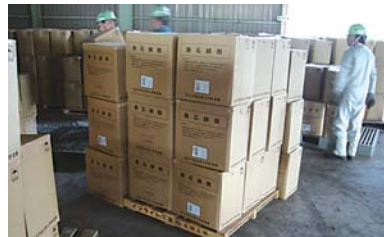
廃石綿の保管
