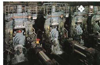
熱間圧延(鋼板)
