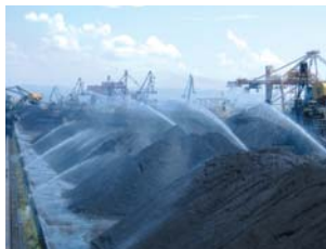
原料ヤード散水
