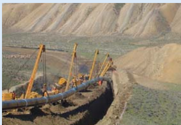
パイプライン
