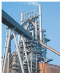
鹿島製鉄所第1号高炉
