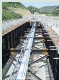
入野橋(仮称)工事状況
