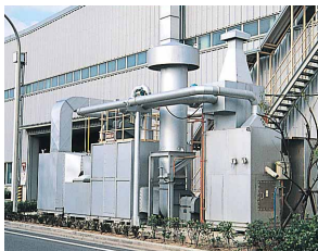
VOC 除去装置（製鋼所）
