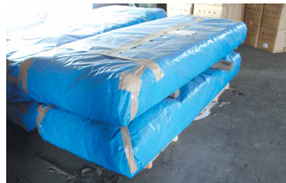
廃石綿の飛散防止状況
