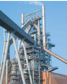
鹿島製鉄所第1号高炉
