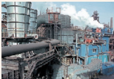
焼結クーラー排熱回収設備（中国／太原鋼鉄）
