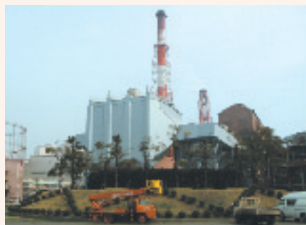
焼結工場排ガス集じん設備(和歌山)
