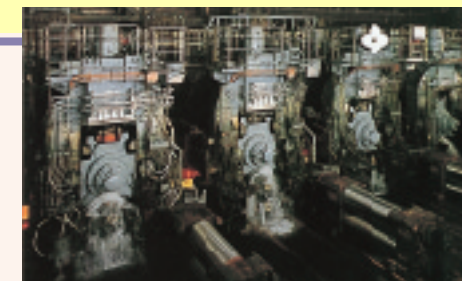
熱間圧延(鋼板)
