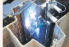
SM-Jパイルの施工状況
