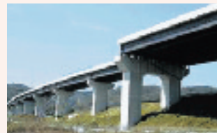
大里高架橋(南九州自動車道 鹿児島)
