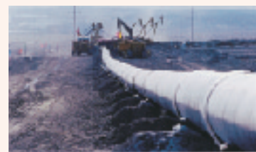
パイプライン
