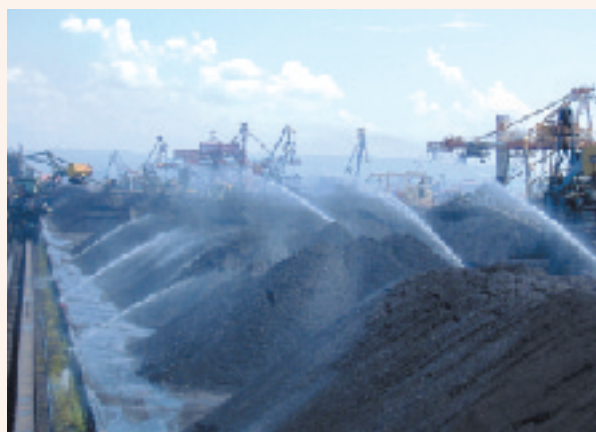
原料ヤード散水
