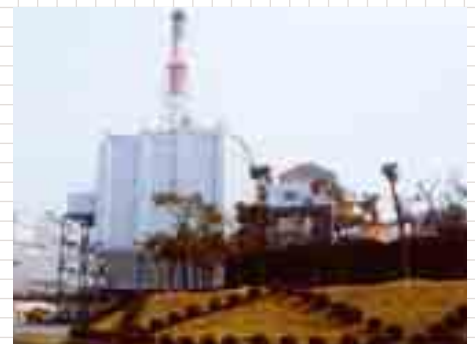
■ 焼結工場排ガス処理設備(和歌山)
