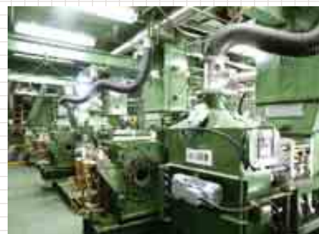
RDF製造装置（宮田市外三町）
