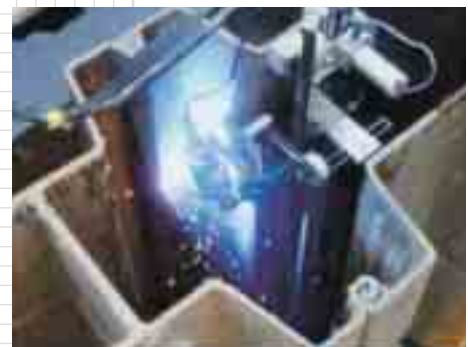
SM-Jパイルを用いた完全遮水工法
