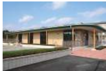
自社保育所 (東日本製鉄所鹿島地区)
