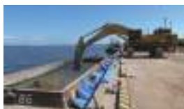
スラグを原料とした改質材の施工
