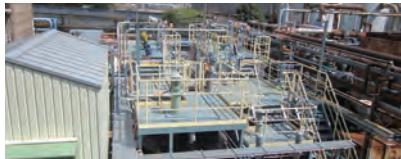
細かな不溶解成分を薬剤で大きな塊にして沈めることにより除去します。
