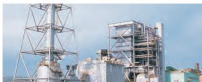
湿式脱硫法により、排ガス中のSOx(硫黄酸化物)を除去します。
