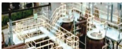
処理した後の排水中に残る不溶解成分を砂の層でろ過し除去します。
