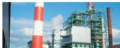
活性コークスを用いた乾式脱硫脱硝法により、排ガス中のSOx(硫黄酸化物)・NOx(窒素酸化物)を除去します。
