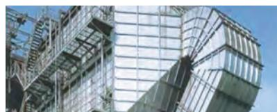
燃焼過程で発生するばいじんをその性状(粒径分布・排ガス中濃度等)に応じて、2種類の集じん機(電気式／バグフィルター式)を使い分けて捕集しています。
