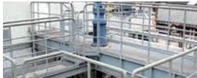
油分を気泡の力で浮かせて除去します。
