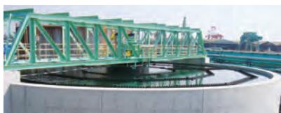
貯留した雨水の不溶解成分を凝集沈殿し除去します。
