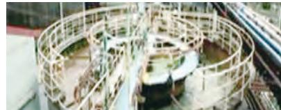
有機物をバクテリアで分解して除去します。
