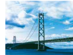
明石海峡大橋に使用されているケーブル
