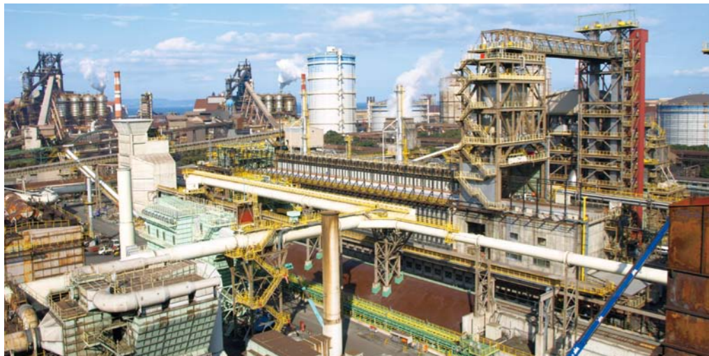
「SCOPE21」の実機第1号プラントである大分製鉄所第5コークス炉（2008年5月竣工）
