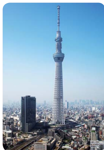
新日本製鉄(株) 東京スカイツリー® 標準的な鋼材の約2倍の強度を実現した新日鉄の鋼材が、世界一のタワーの高さを支えています。さらに鋼材の薄手化により製造から加工段階までのCO 2 削減にも貢献しています。
