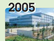
第1号となった施設(北九州)
