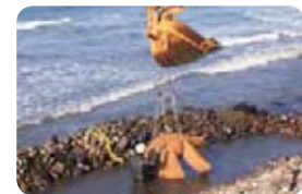
鉄分供給ユニットの設置
