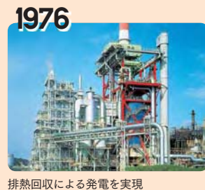
排熱回収による発電を実現
