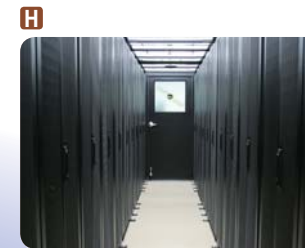
新日鉄ソリューションズ(株) 衛星データ解析用システム 人工衛星「いぶき」のデータを基に温暖化ガスの観測データを解析する、スーパーコンピューターを研究・開発。世界のCO 2 排出量の詳細な分布の解析が実現しました。当社の新システムのデータ処理能力は、世界のスパコンの電力効率を競うランキング「Green 500」で2010年のトップ10にランクインしています。
