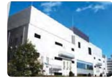
環境性能で日本をリードする新日鉄ソリューションズの第5データセンター
