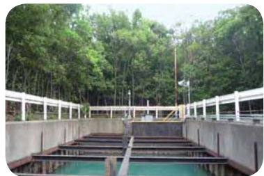
緊急排水遮断設備(堺製鉄所)
