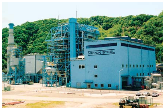
釜石製鉄所の電力工場
