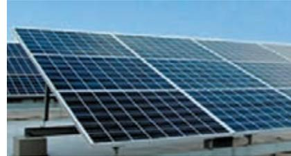
マンションの屋上に太陽光パネルを設置。170kW相当の電力をつくり、マンションの共用部分に供給します。森林面積に換算すると東京ドーム48個分に相当するCO<sub>2</sub>を削減します(約62t/年)。
