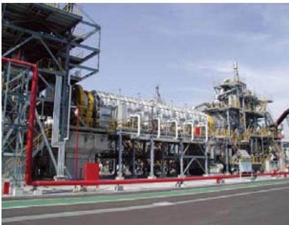
廃タイヤのガス化リサイクル炉（広畑製鉄所）
