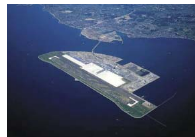
スラグの有効活用（中部新国際空港）
