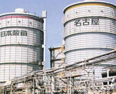
新設したガスホルダー（名古屋製鉄所）
