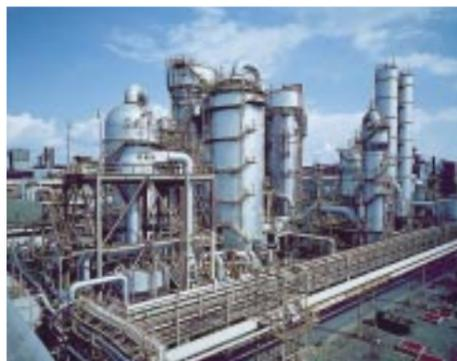
コークス炉ガス脱硫設備
