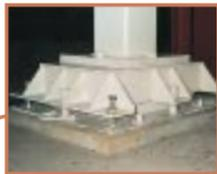
柱と基礎の間に免震装置を設置
