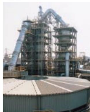
回転炉床式ダストリサイクル設備(君津製鉄所)
