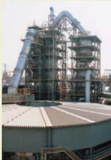
ダストリサイクル設備(君津製鉄所)
