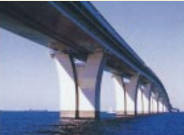
東京湾横断道路のチタンクロッド鋼橋脚
