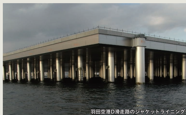
羽田空港D滑走路のジャケットライニング
