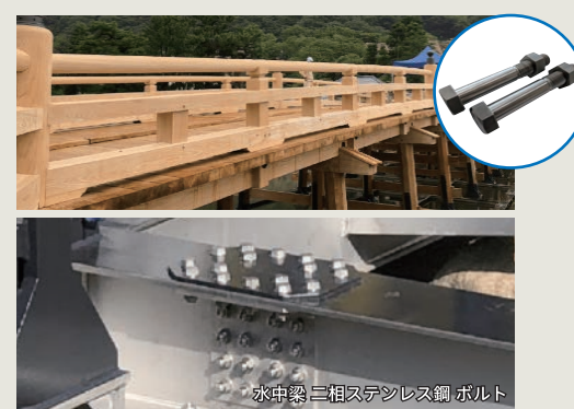
水中梁 三相ステンレス鋼 ボルト
