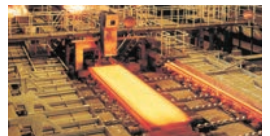
第3連続鑄造設備 No.3 Continuous Casting Machine
