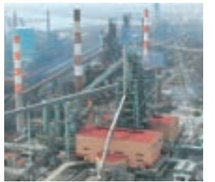
第一高炉 Kashima No.1 Blast Furnace
