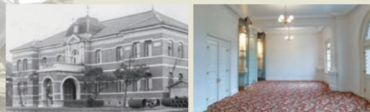
操業2年前の明治32年頃に竣工した旧本事務所。 2年半の歳月をかけて2020年9月に内装整備工事完工(2F会議室)
