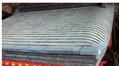
葺き替え工事前の住吉神社屋根
