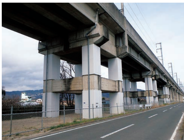
補強工事を終えた高架橋（新幹線）
