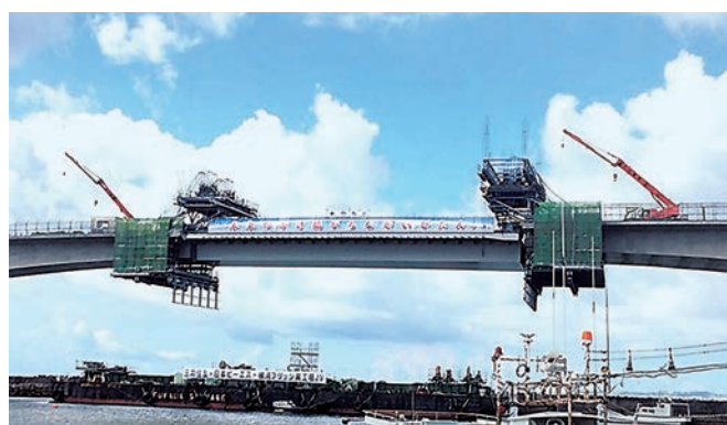
牧港高架橋（沖縄県）
