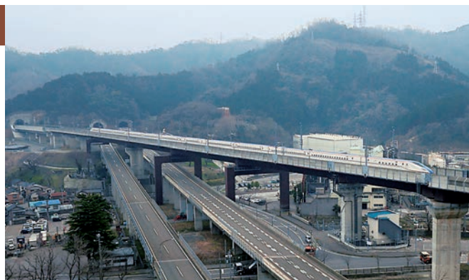
北陸新幹線北陸道架道橋（新潟県）
