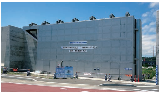
陸閘門(岩手県)
