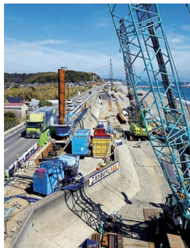
高知海岸での施工状況
