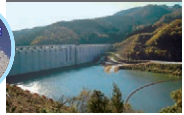
茨城県・小山ダム
