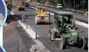
東九州自動車道門川舗装工事
