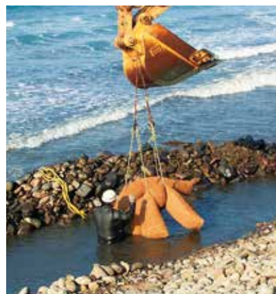
増毛での鉄分供給ユニット埋設作業の様子
