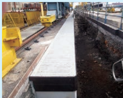
ECMコンクリートの打込み後の状況
