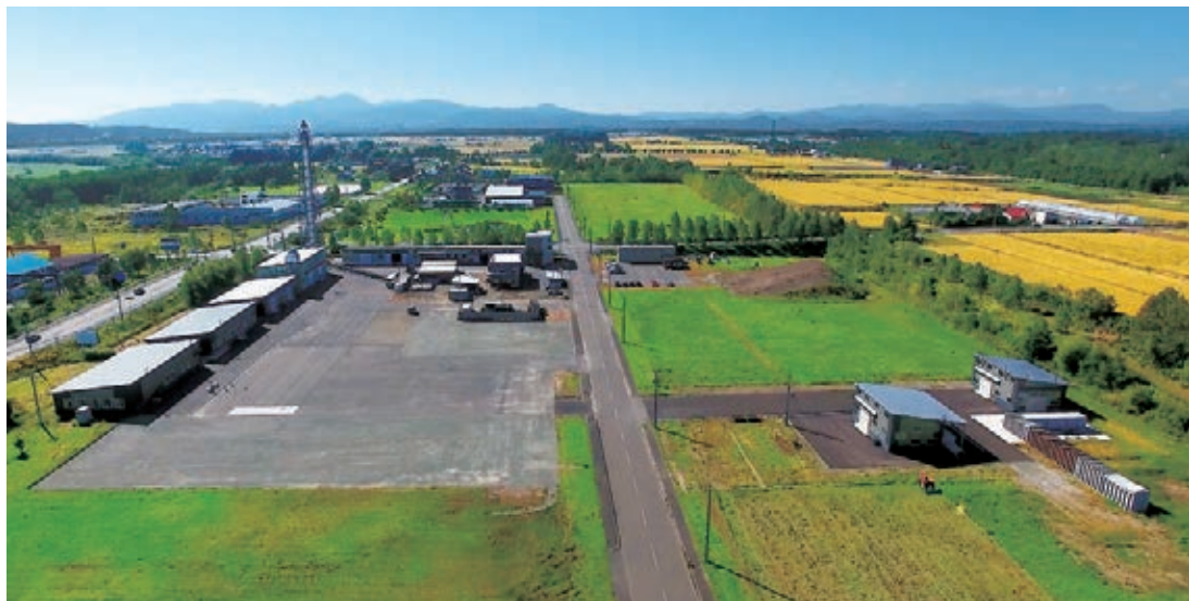
ARCプロジェクトは、会社の敷地に1つの街をつくるイメージで進められている
