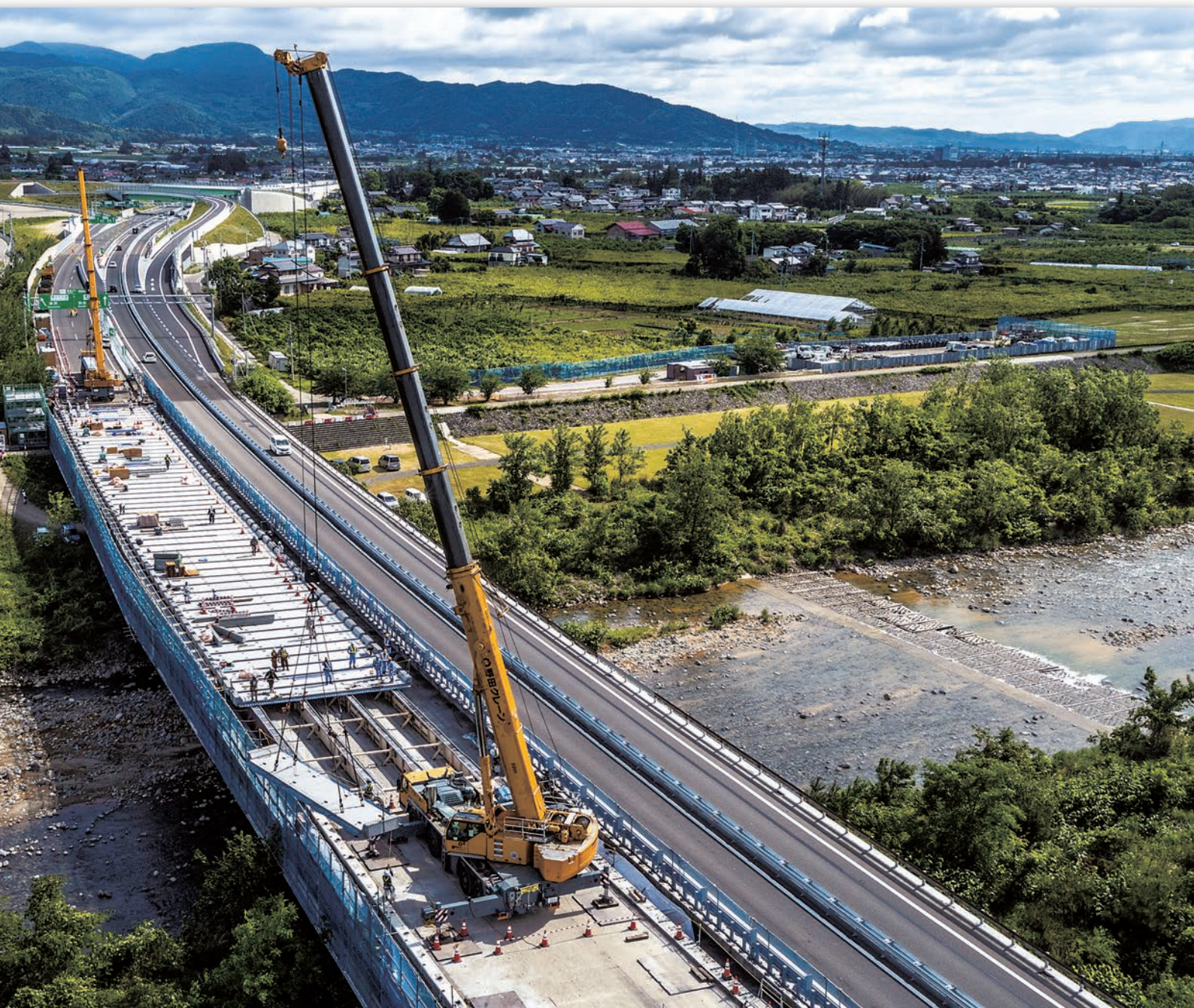
床版取り替え工事
