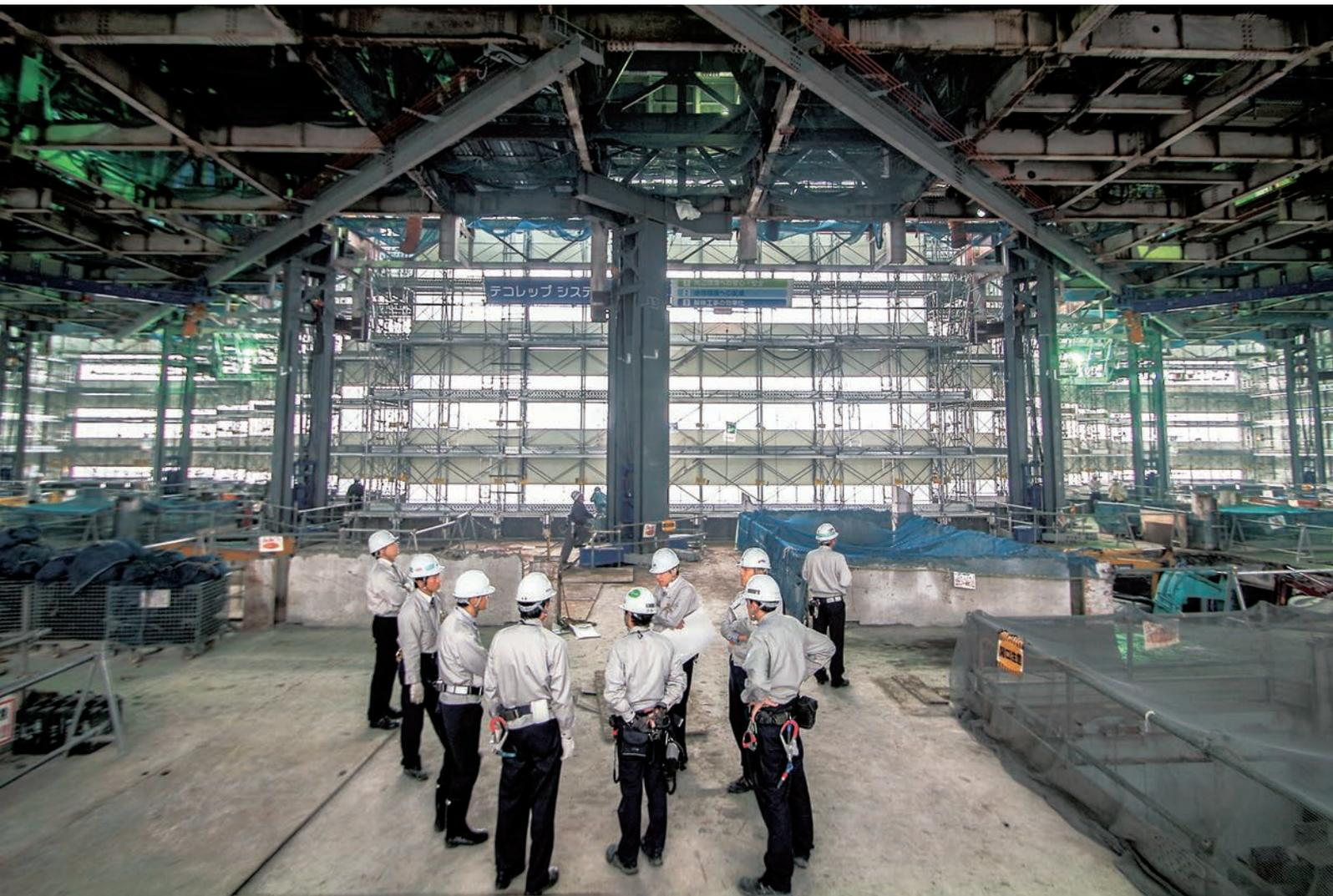
解体工事の内観 既存の屋根と足場で包み込むように囲い、安定した解体作業空間をつくり出している。
