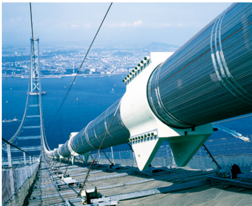
明石海峡大橋
