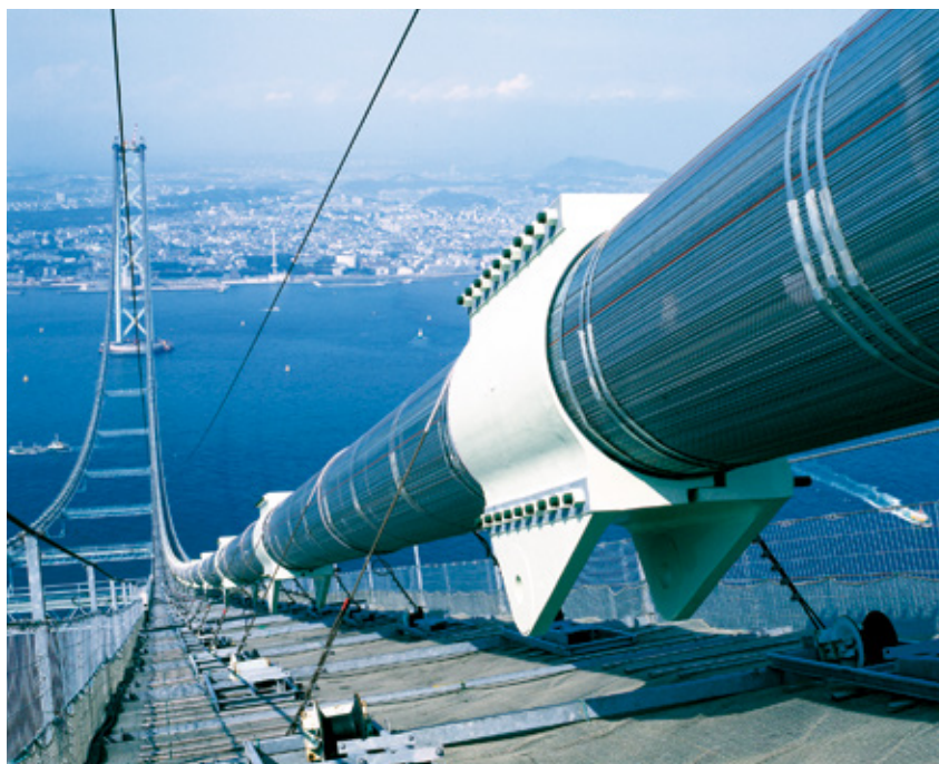
明石海峡大橋
