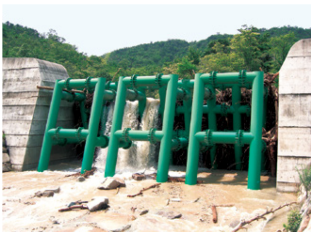
鋼製スリットダム施工例
