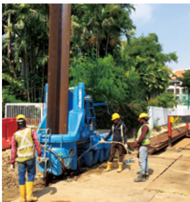
左からシンガポール、豪州のハット形鋼矢板の打設状況
