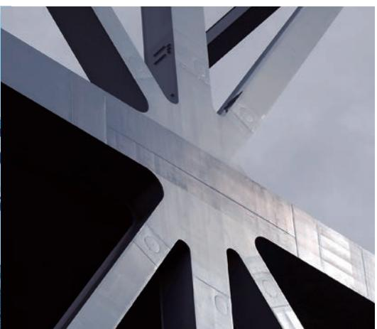
写真3 コンパクト格点<sup>※4</sup>構造
