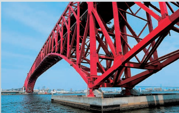
港大橋(全長980 m)
