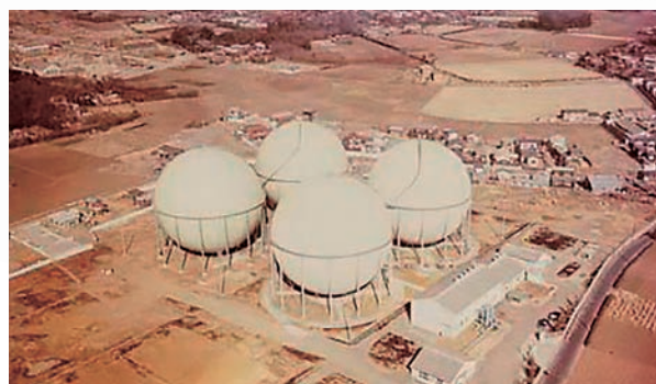
都市ガス用球形タンク(東京ガス世田谷整圧所)
