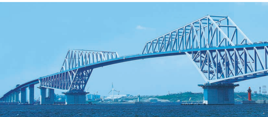
写真2 東京ゲートブリッジ
