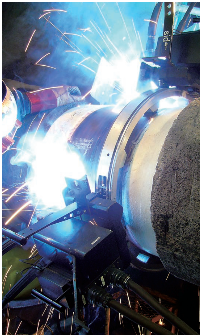
敷設船での自動溶接
