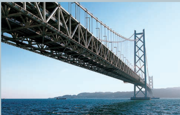
明石海峡大橋(全長3,911 m)
