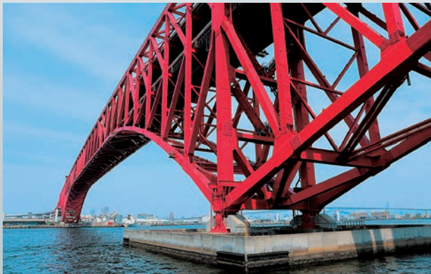
港大橋(全長980 m)
