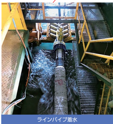
「くろしお」による海底パイプラインの敷設
