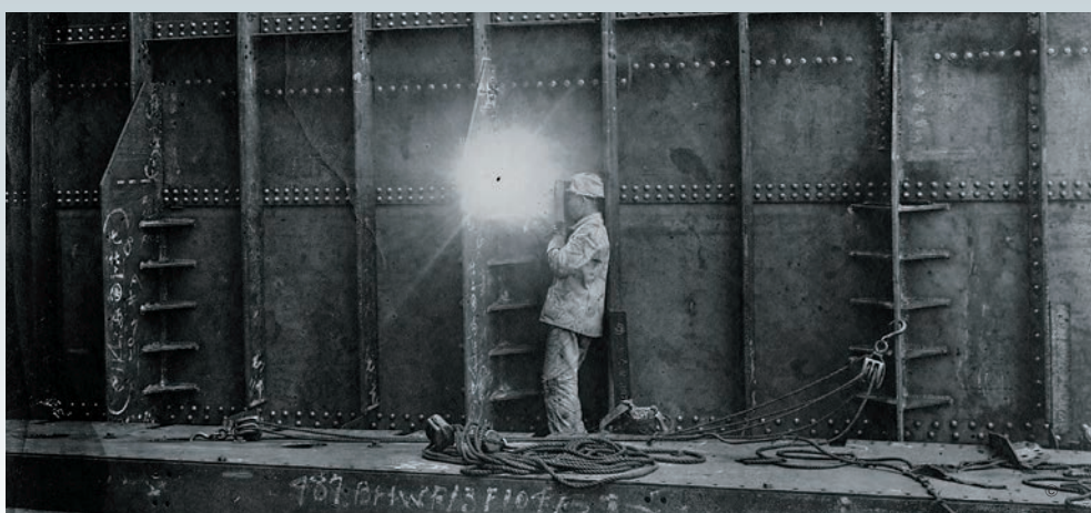
大正時代の電気溶接
