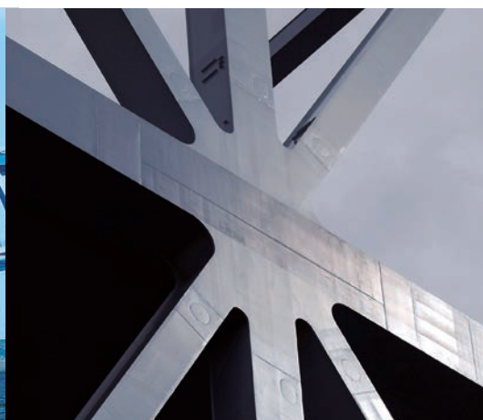
写真3 コンパクト格点 ※4 構造
